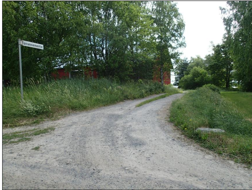
Vesihuoltolinjaa Torraniementien etelälaidan viettävässä penkassa. Koilliseen.
