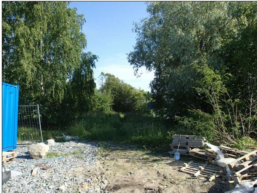
Vesihuoltolinjan eteläpäästä Ristimäessä. Peitteisellä alueella jo aiemmin kaivettua linjaa vesihuoltoputkelle. Pohjoiseen.
