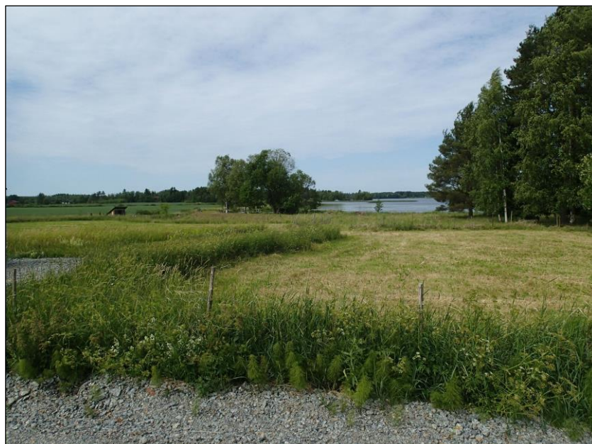
Vesihuoltolinjaa Nokkakyläntien päässä pellonlaidassa. Länteen.
